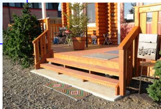
階段の手すりが完成
