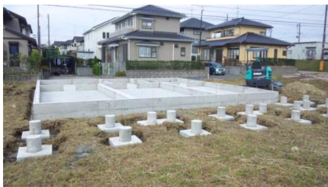
「いわきサポートステーションもみの木」となるログハウスの土台
