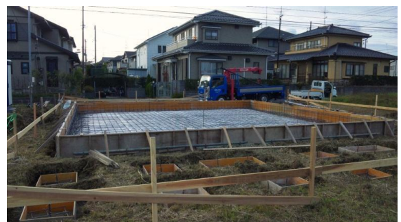
いわきサポートステーション「もみの木」の建設現場
