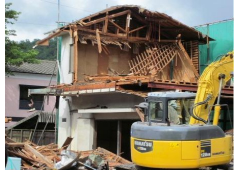
写真：撤去の始まった湯本教会のお聖堂
